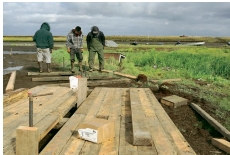
Zu den Nachbarn geht Maria Fairbanks über Holzplanken, die liegen überall im Dorf. Aber sie verrotten immer schneller, seit der Permafrostboden taut
